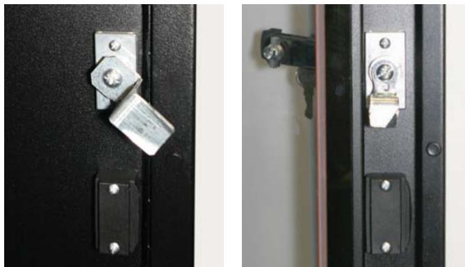
В шкафах с одностворчатыми дверями механические тяги не применяются. Запирание двери производится только в одной точке – посредине шкафа.
