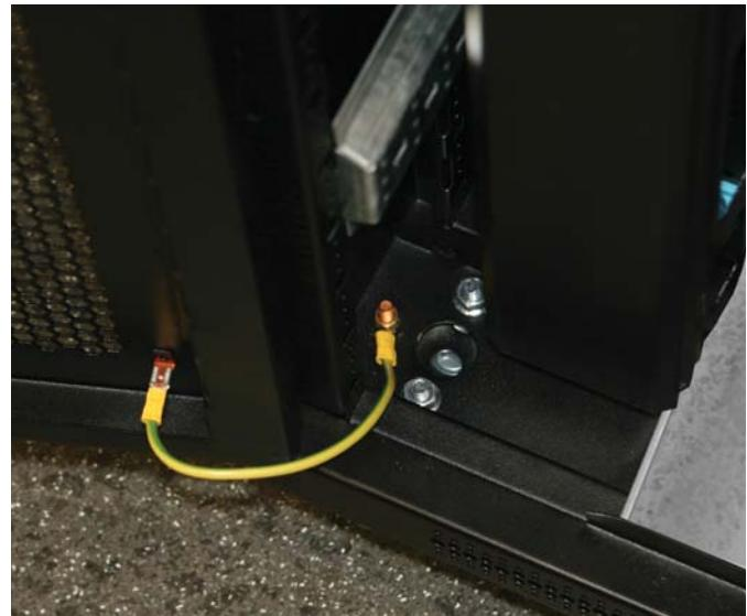
Используя заземляющие провода, подключите все металлические элементы шкафа к предусмотренным для них узлам заземления. На завершающем этапе подключите главный заземляющий контакт шкафа к существующей в здании общей системе заземления.
